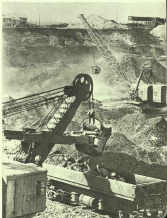
Le bassin houiller de Karaganda. L'exploitation à ciel ouvert n° 1.
